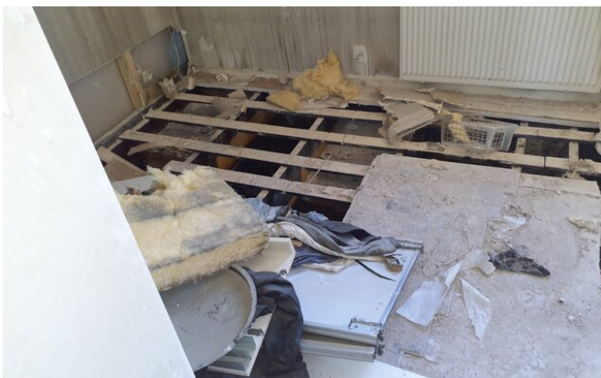
Yläkerran makuuhuone, välipohjarakenne auki alas.
