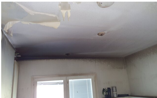
Makuuhuone katto js seinät
