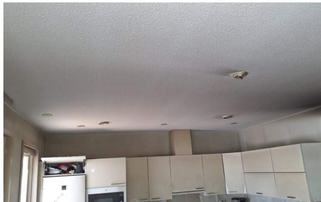
Olohuone-keittiö tilan katto.
