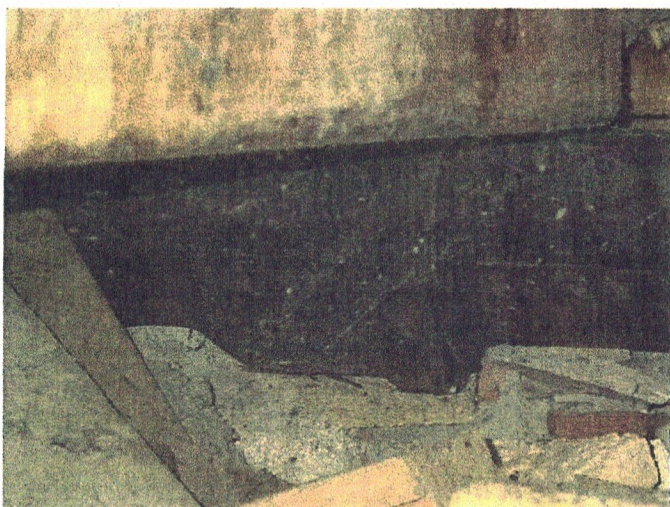
Alapohjarakenteessa kulkevan viemärin liitos on tarkistettava. Lattiassa kuivumisesta aiheutunutta alunaa.
