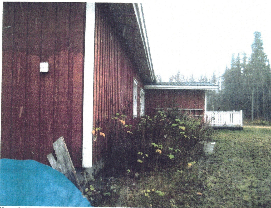
Kuva 2. Kasvustoa on sokkelin ja ulkoseinän välittömässä läheisyydessä.
