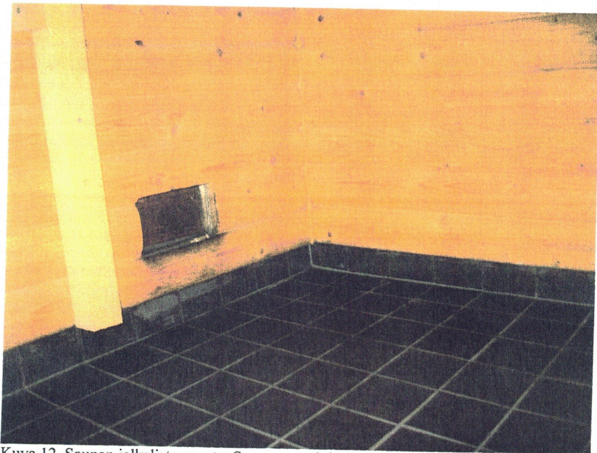
Kuva 12. Saunan jalkalistan nosto. Saunan panelointi on asennettu savupiippua vasten.
