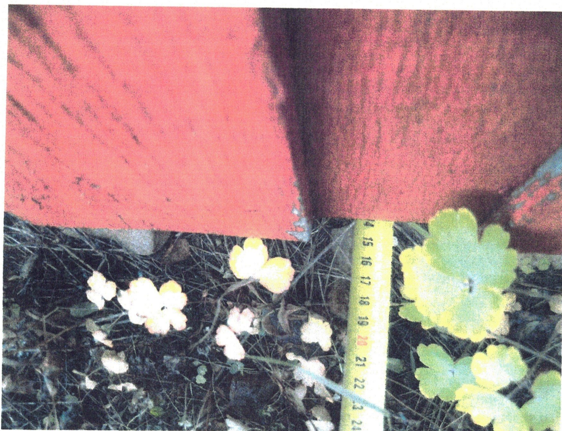
Kuva 5. Ulkoverhouksen etäisyys sokkelin betonipinnasta mitattuna.
