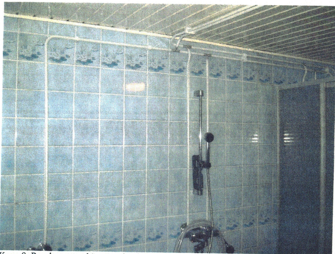
Kuva 9. Pesuhuonetta, käyttövesiputket on asennettu pintaan.
