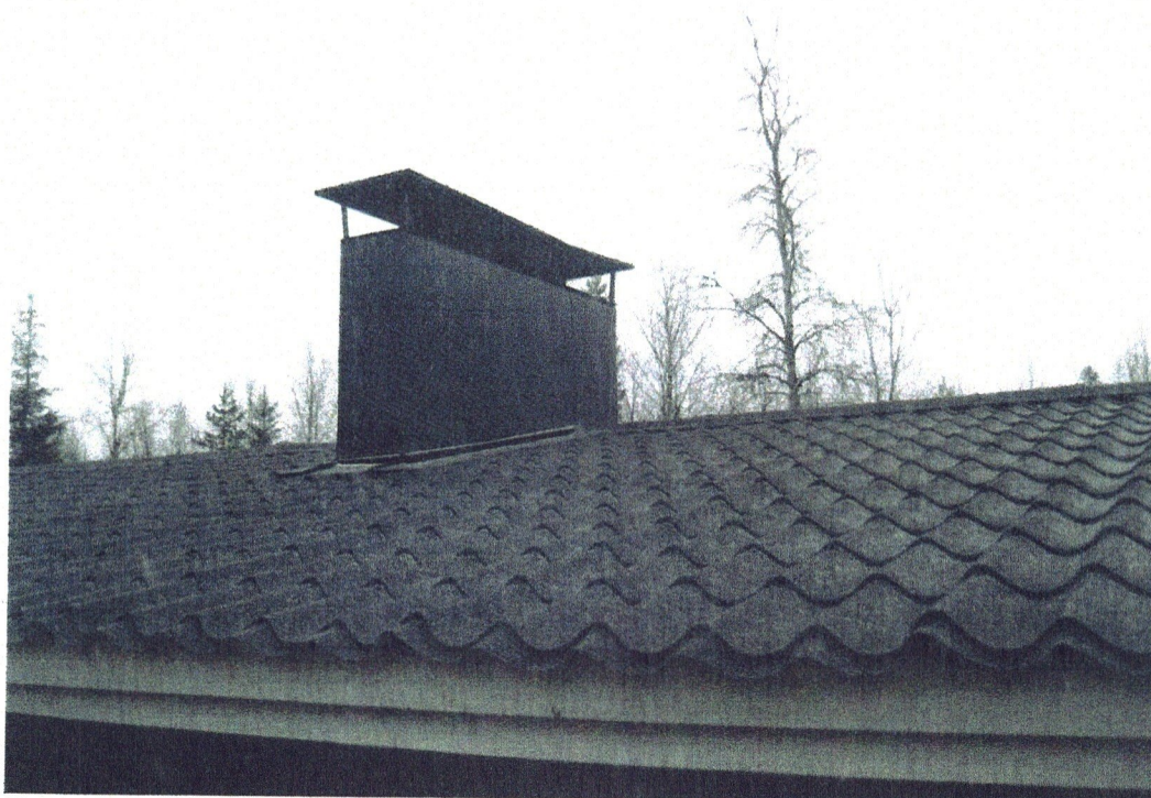
Kuva 6. Toinen savupiippu on harjalla, läpivienti näyttää asialliselta
