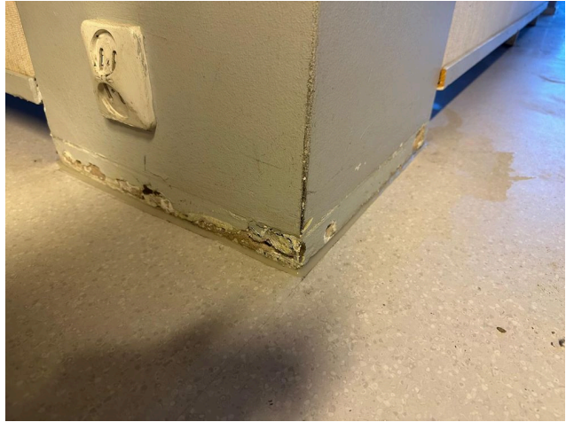
Timo Ilola 05.03.2025 14:18 Urakoitsijan ottama kuva, pilarin juuri tiivistetty
