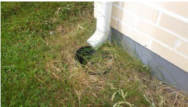
9. Rännikaivo syöksytorven kohdalla
