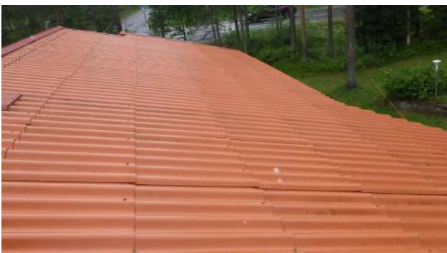
19. Rakoa vesikatelevyjen limityskohdissa
