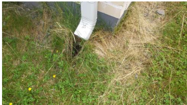
10. Rännikaivo syöksytorven kohdalla
