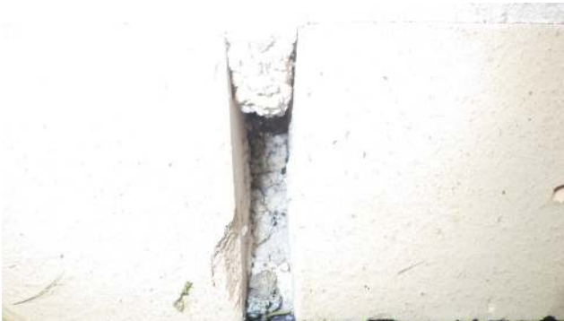
13. Tiiliverhouksen alaosan tuuletusaukko on osittain laastin täyttämä
