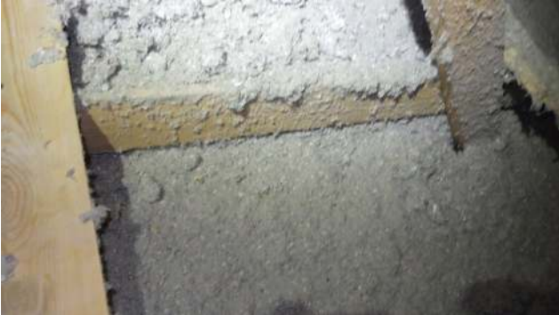
31. Lämmöneristevahvuus vaihtelee.
