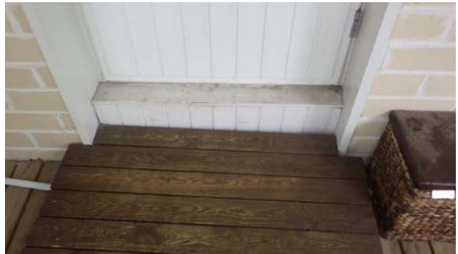
18. Kynnyspeltti puuttuu
