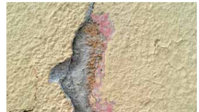
Kuva talon A ulkoseinän ulkopinnasta.
