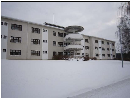
Rakennus 7, Hoivakoti ja hotellitilaa
