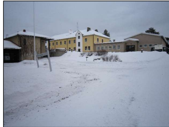
Rakennus 2 ja 3, osittain saneerattavina
