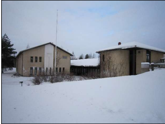
Rakennus 5, Kylpylä/spa, kehityskohde
